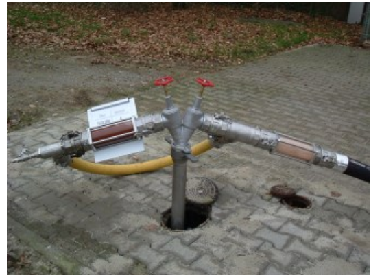
Rohrnetzspülung: Hydrantenstandrohr mit Schaugläsern zur Beobachtung des Spülverlaufes
