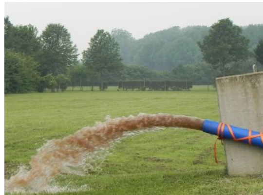
Spülung einer Rohwasserleitung Ausgespült am Brunnenkopf
