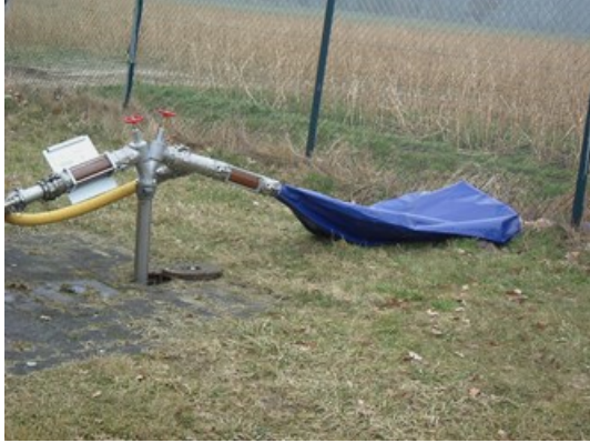
Rohrnetzspülung: Spülwasserauslass über Spültuch
