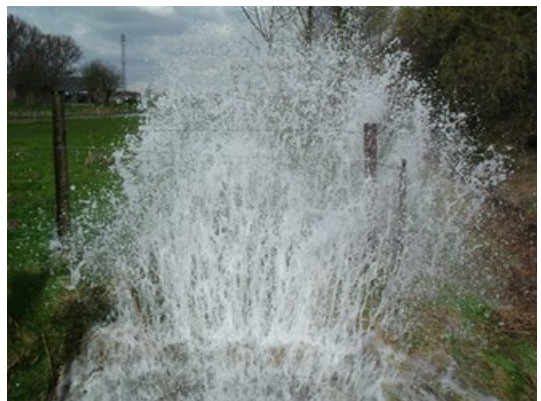
Spülwasserauslass über Entleerungsanschluss (Froschklaappe)
