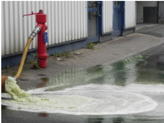
Spülung einer Kaltwasserleitung (Kühlwasser in der Industrie)
