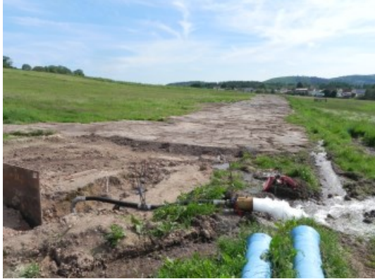
Spülung einer neuverlegten Transportleitung zur Unterstützung der Desinfektion
