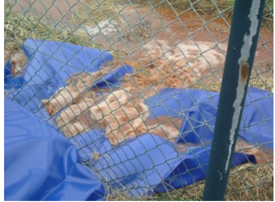
Rohrnetzspülung: Spülwasserauslass über Spültuch
