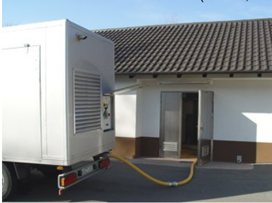
Lufteinspeisung in der Wasseraufbereitungsanlage
