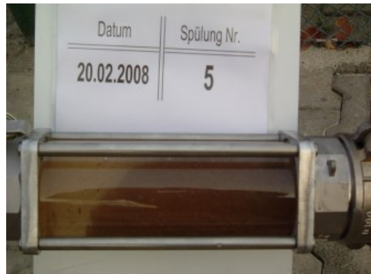
Rohrnetzspülung: Schauglas zur Fotodokumentation der Spülung
