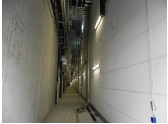
Spülung einer Kaltwasserleitung (Kühlwasser in der Industrie)
