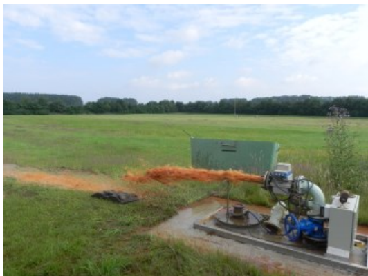
Spülung einer Rohwasserleitung Ausgespült am Brunnenkopf
